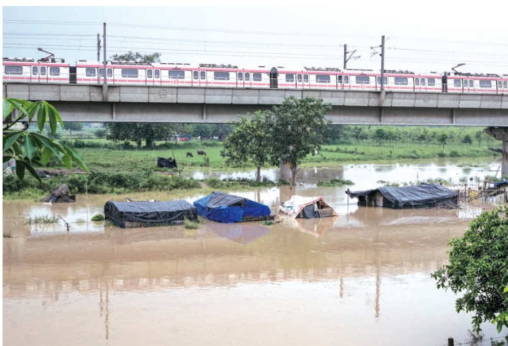
दिल्ली में मंगलवार को यमुना नदी का जलस्तर बढ़ने के कारण नदी किनारे बसे लोगों के घर डूब गए फोटो-पीटीआई
